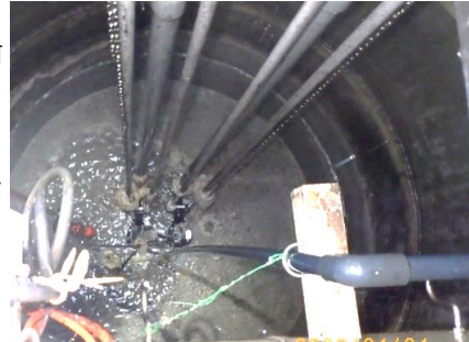
中継・分配ポンプ槽 旋回流発生装置設置前
