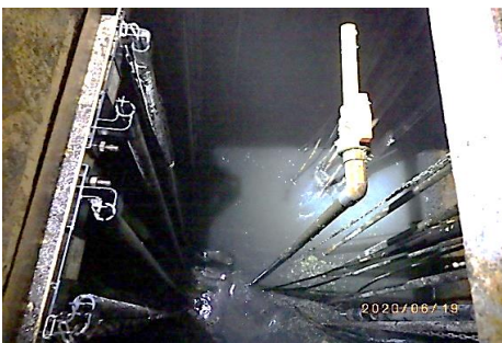
中継・分配ポンプ槽 旋回流発生装置設置後
