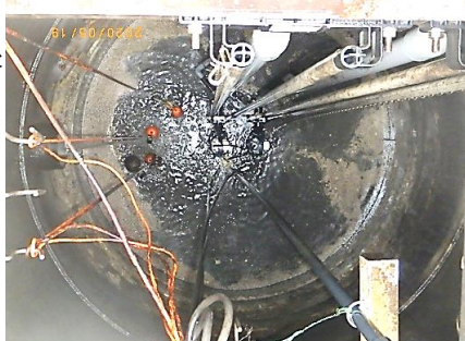
中継・分配ポンプ槽 旋回流発生装置設置後
