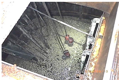
中継・分配ポンプ槽 旋回流発生装置設置前
