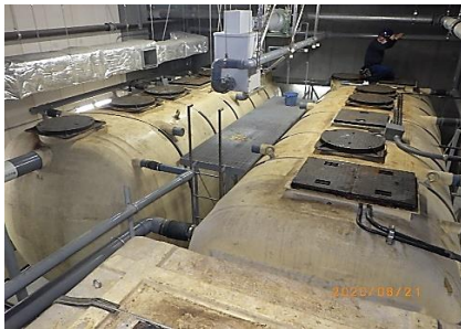
ディスポーザー排水処理槽 脱臭システム設置前
