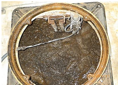
好気処理槽 脱臭システム設置前
