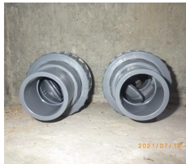
新たに設置のスイング逆止弁
