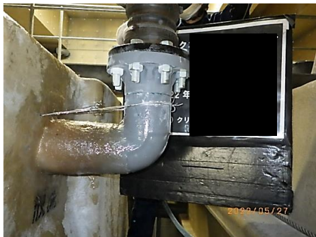
放流ポンプ配管 補修
