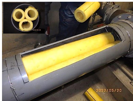
臭気ファン騒音 消音器設置
