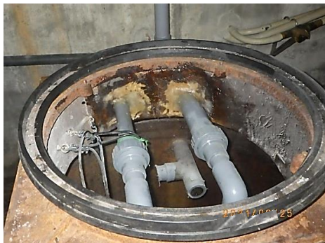
放流ポンプ配管 修繕
