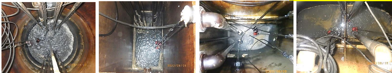
油脂ゼロポンプ槽に改修の4例
