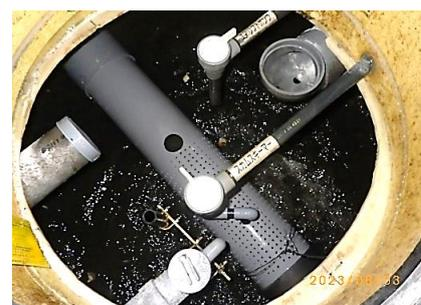
当該処理槽の担体は、破損し沈殿分離槽にまで流下移行します。
