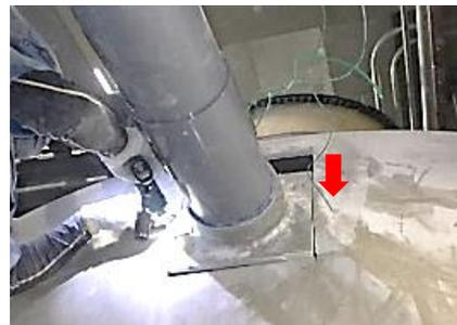
当該処理槽は2槽の連結ですが、連結移行配管に勾配がなく、移行配管内は常に、満水に近い異常水位です。
