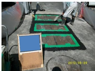
開口蓋の受枠交換工事
