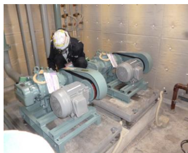
ブロワー交換工事
