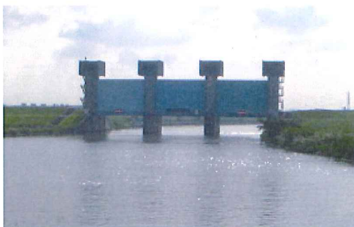
新岩淵水門：青水門
